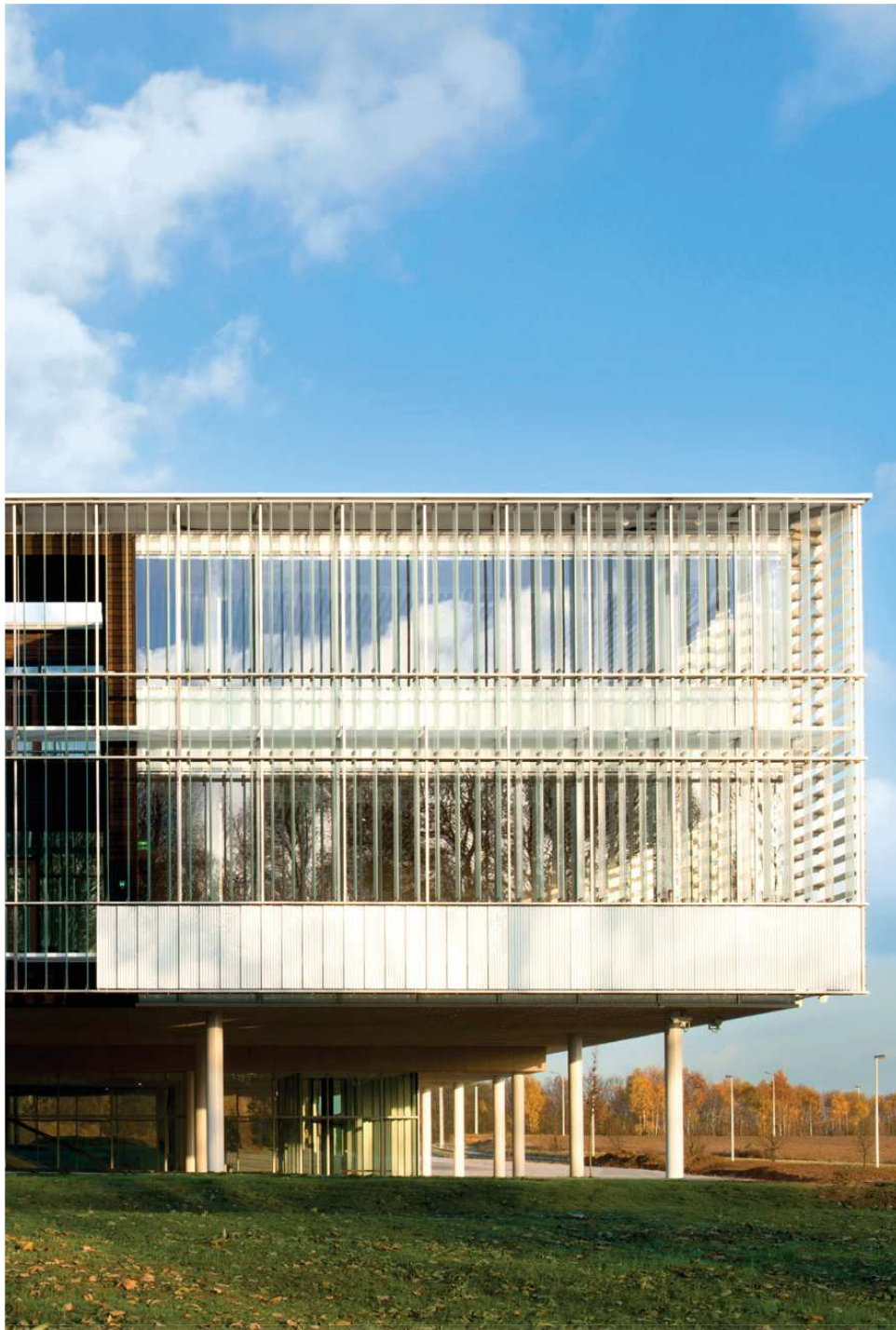
AGC Glass Building - Louvain-la-Neuve, Belgique - Architecte : Philippe Samyn and Partners sprl, architects and engineers - BEAI sa - Persiennes en verre à partir de verre Planibel Clearvision, Thermobel TopN+, Lacobel T. © AGC Glass Europe - Photographe : Marie-Françoise Plissart
